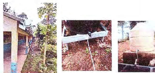
Foto 6: Instalación de canales y bajadas de agua pluvial para abastecer la pila y el tinaco que ya se cuenta e instalación de un nuevo tinaco que abastecerá a las necesidades de consumo y limpieza a los estudiantes del centro educativo.
