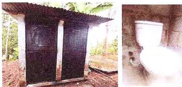
Foto 5: Instalación de 2 puertas de metal a las 2 letrinas lavables de la Escuela Oficial Rural Mixta Chucutá La Unión que brindará mayor seguridad a los niños y niñas. Y colocación de los accesorios a los 2 sanitarios.
