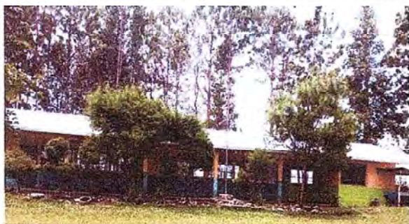
Foto 1: Finalización del cambio de techo de tres aulas y la dirección de la Escuela Oficial Rural Mixta Chucutá La Unión juntamente con las vigas de metal.
