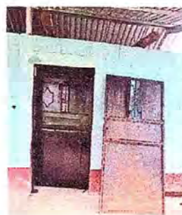
Foto 4: Finalización del cambio de la puerta de la cocina de la Escuela Oficial Rural Mixta Chucutá La Unión.
