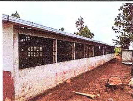
Foto 3: Colocación de balcones para darle seguridad a las ventanas de vidrio en la parte de atrás de la Escuela Oficial Rural Mixta Chucutá La Unión.
