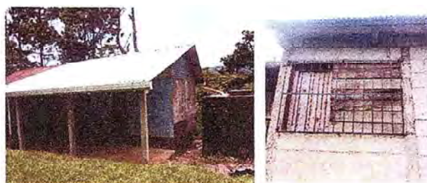
Foto 2: Culminación del cambio de techo de la cocina de la Escuela Oficial Rural Mixta Chucutá La Unión que incluye también las láminas del corredor de la misma. Asimismo colocación de un balcón en la ventana de la parte de atrás.
